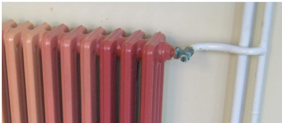
Сл. 7, Изглед на главата на постојните радијаторски вентили
