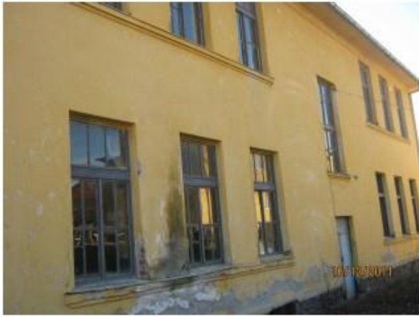
Сл. 9, Оштетување на фасада и протекување
