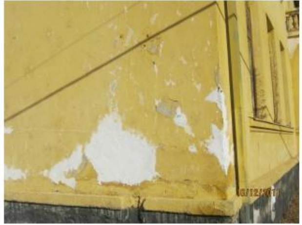
Сл. 9, Оштетување на фасада и протекување
